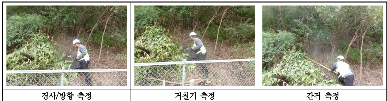
【사진 15.3.2】 불연속면 측정 현황
